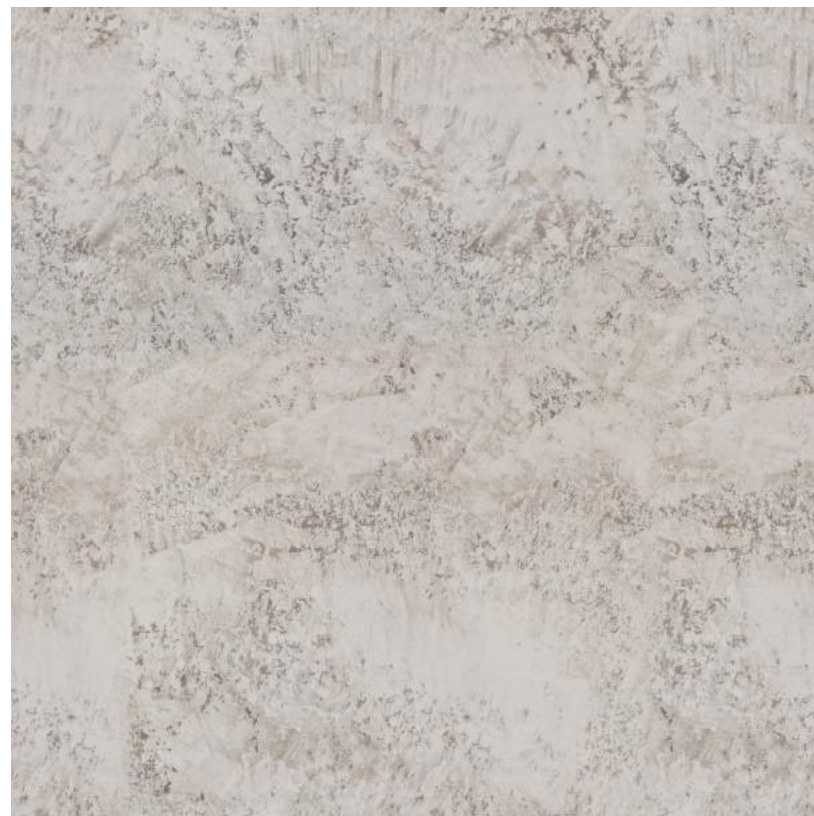
Вид отделки стен №7. Декоративная штукатурка. Образец покрытия
